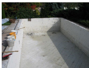
Nach dem Entfernen der Fliesen wird ein Vlies und eine Folienauskleidung verlegt
